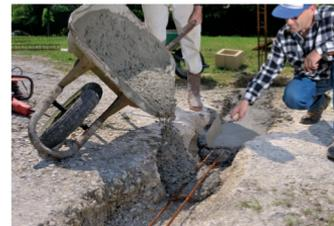
Viga de cimentación en concreto impermeable
