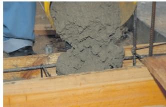
Concreto seco (difícil de instalar)
