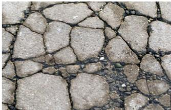
Concreto de baja resistencia por exceso de agua en la mezcla
