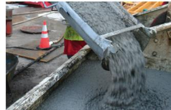
Concreto fluido con Sika®Cem Plastificante (fácil de instalar, sin afectar la resistencia)
