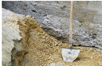
Concreto de baja resistencia por huecos internos (cangrejas) debido a concreto muy seco al colocar
