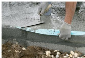
Placa de contrapiso sobre el suelo con concreto impermeable
