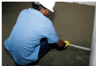
Afinado de placa de cubierta con mortero impermeable
