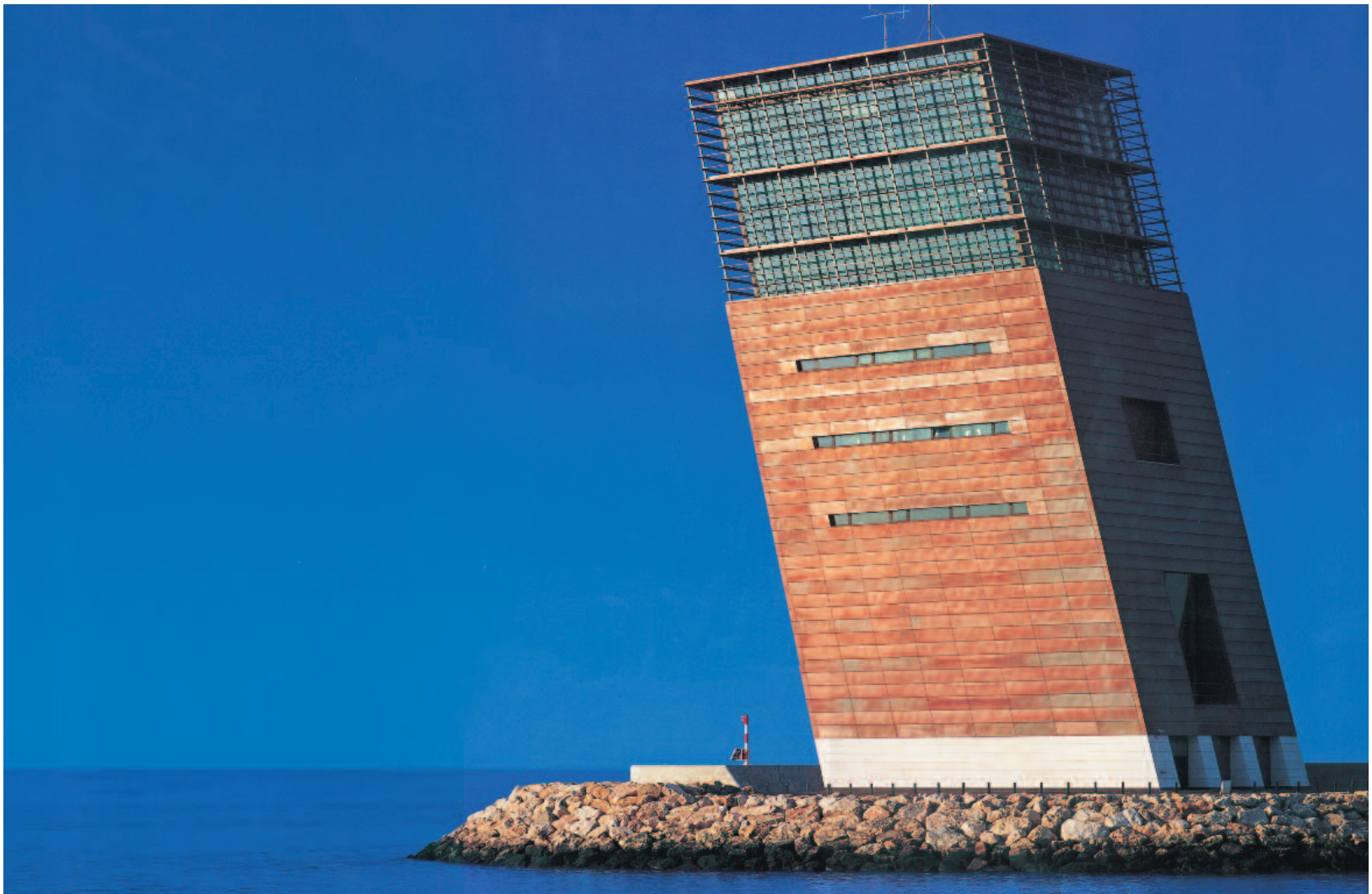
Torre de control del puerto de Lisboa
