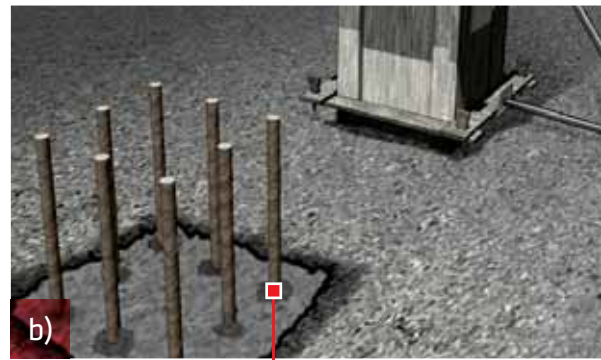
b) Relleno con Sika®Anchorfix® Sikadur® 31
