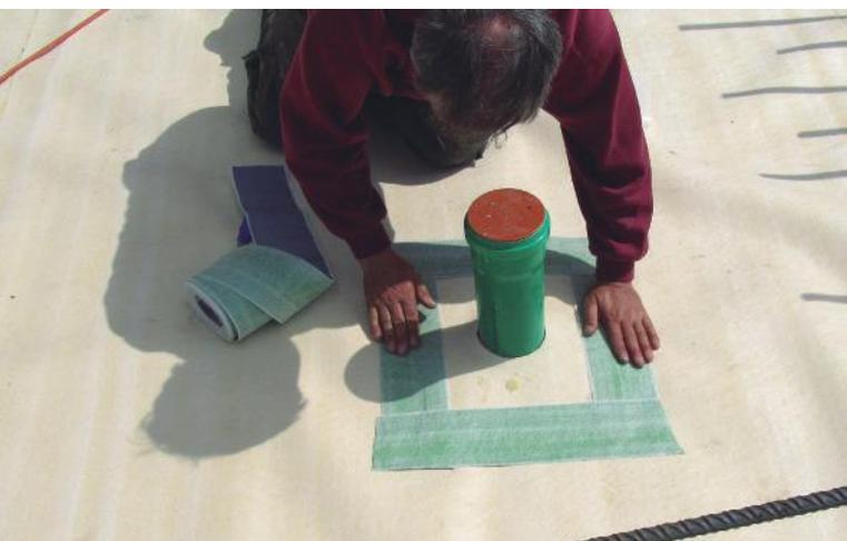
Detalle de penetración de tuberías con **SikaProof® Tape -150**
