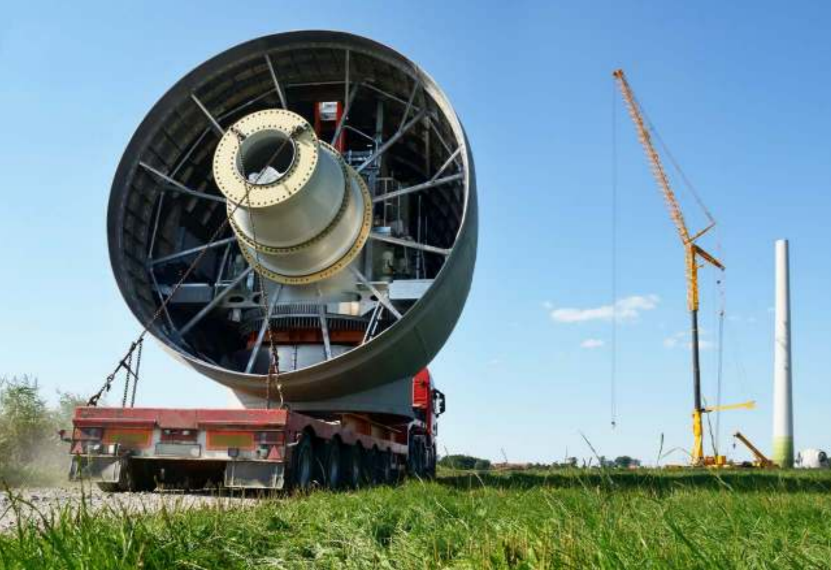
Transporte del eje hasta el lugar de montaje de la turbina.
