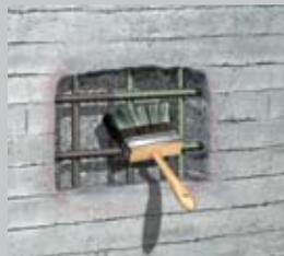
4. Finalizada la colocación, el Sika Rep PE se debe curar con agua o con curador químico.
