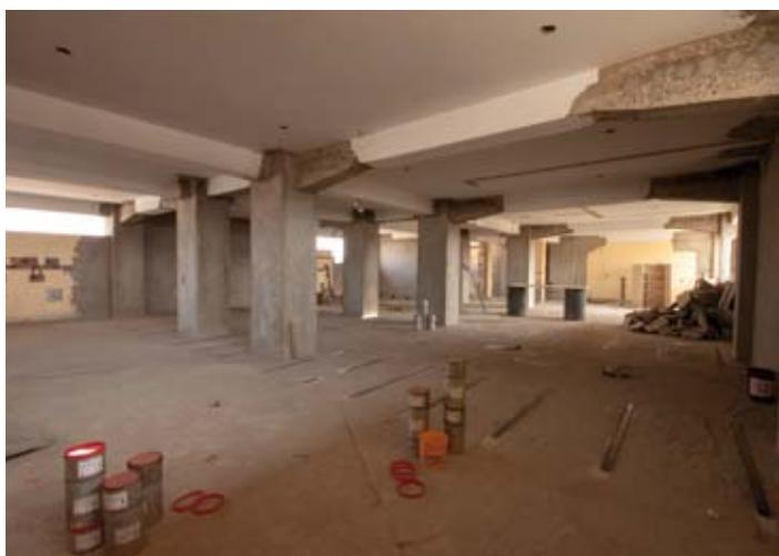
“ Las estructuras del segundo y tercer piso de la Unidad de Cuidados Intensivos del hospital debían ser reforzadas para soportar equipos mucho más pesados de los que podía soportar anteriormente. Para ello un grupo de ingenieros de la UNI recomendaron el reforzamiento con fibras de carbono de la línea Sika CarboDur. material que logramos instalar satisfactoriamente mediante un trabajo en conjunto. Los resultados logrados fueron los que esperamos desde un comienzo. ”
