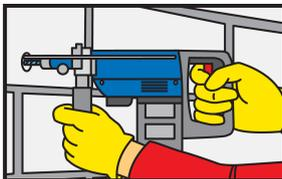
1. Realizar la perforación con el diámetro y profundidad requeridos. El diámetro de la perforación debe ser de acuerdo al diámetro del anclaje.
