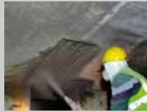
REPARACIÓN DE HORMIGÓN
