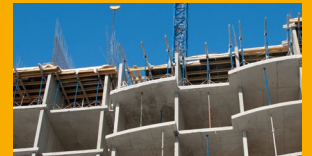
FUNDICIÓN IN-SITU Y PREFABRICADOS DE CONCRETO
