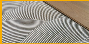
INSTALACIÓN DE PISOS
