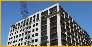
REPARACIÓN DE CONCRETO
