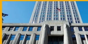
REPARACIÓN Y PROTECCIÓN
