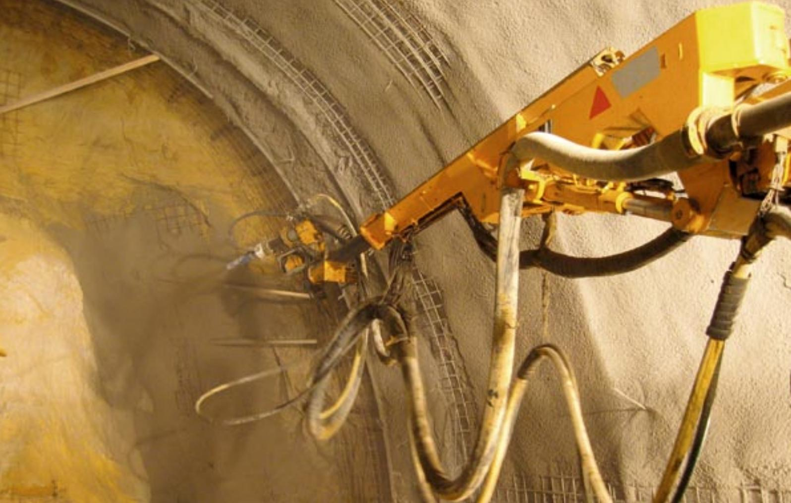
■ La cantidad de material de rebote es un factor de costo crucial. Adicional a la carga, el transporte y la disposición del material de rebote, los costos de rebote también incluyen el Concreto Projectado extra que se debe producir y aplicar.
