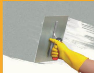
2 Aplique **Estuka® Acrílico** con llana metálica mínimo 2 capas y deje secar entre capa y capa 1 hora
