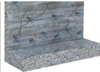
3. Fije la válvula anti retorno (sin retorno) en el primer packers y comenzar el proceso de inyección en la fila más baja de las perforaciones.
