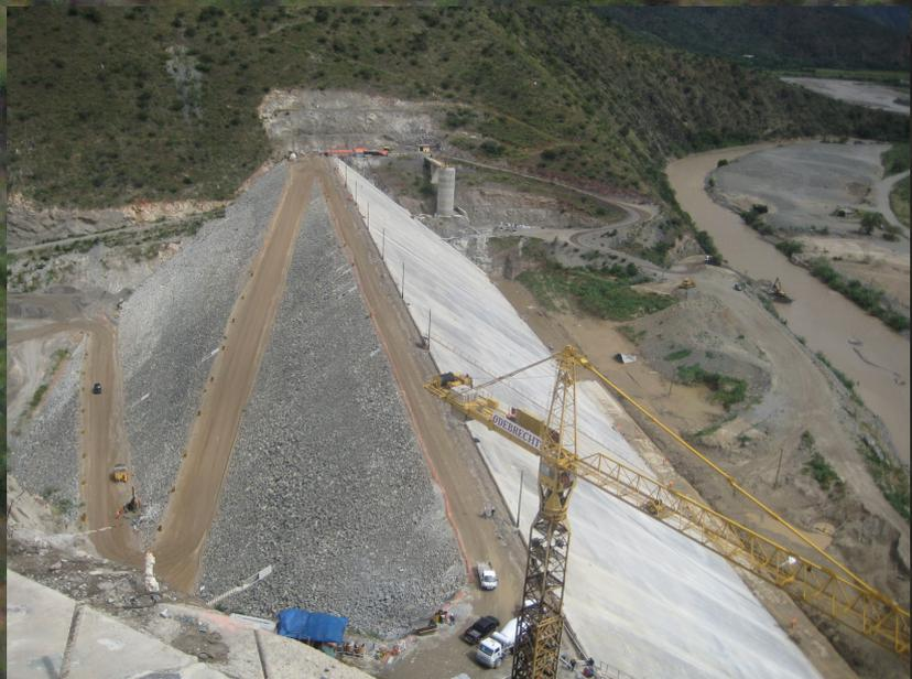
Para tal difícil tarea de manejar la mezcla de shotcrete se utilizan los aditivos **Sikament 306** como súper plastificante, el **Sika Tard PE** para mantener la mezcla fresca sin perder trabajabilidad durante el transporte y los trabajos previos al lanzado y durante el lanzado nuestro acelerante libre de álcalis de la serie **Sigunit L-50 AF**, cabe resaltar que la mezcla de shotcrete lleva fibra de acero **Sikafiber LHO 45/35 NB**.
