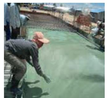
Terminada esta labor y una vez el concreto haya endurecido suficientemente, se efectuará un afinado con la allanadora y/o con llana manual hasta obtener un acabado liso y homogéneo.
