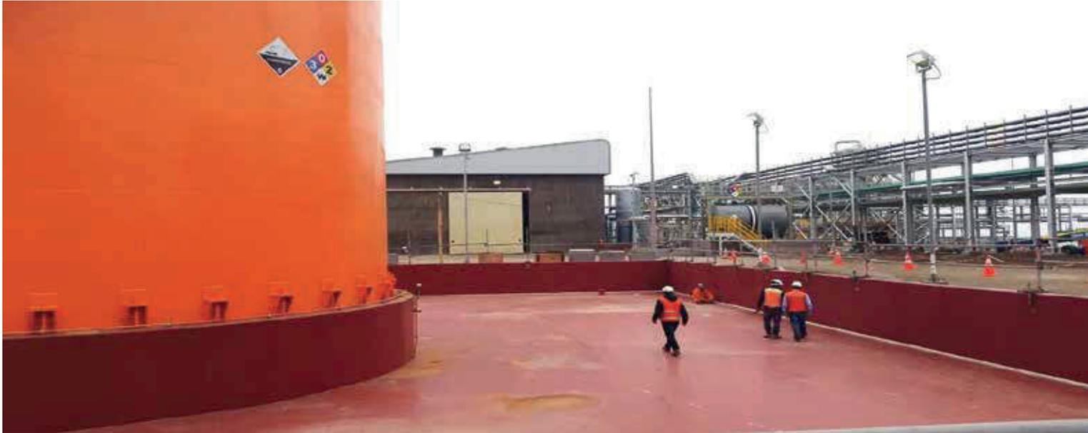
Revestimiento epóxico-novolac bi-componente, 100% sólidos, de muy alta resistencia química. Aplicable en recintos de tráfico severo. El Mortero Sikaguard 5300 Antiácido, se aplica en espesores de 3 a 5 mm.
