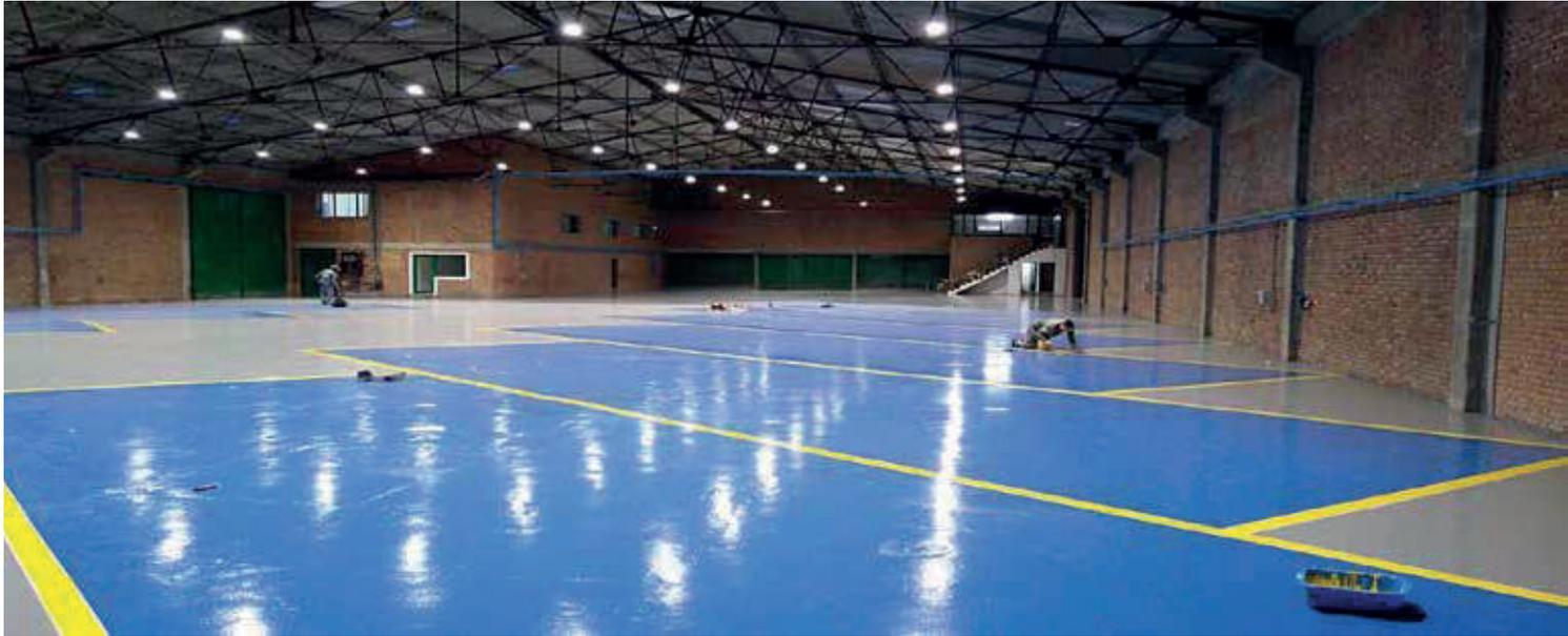
Recubrimiento polimérico, tipo acriluretano alifático de dos componentes, catalizador tipo isocianato utilizado como capa de acabado de sistemas epóxicos para la protección y decoración de estructuras metálicas y de concreto expuestas a la intemperie y a los rayos UV en ambientes agresivos.
