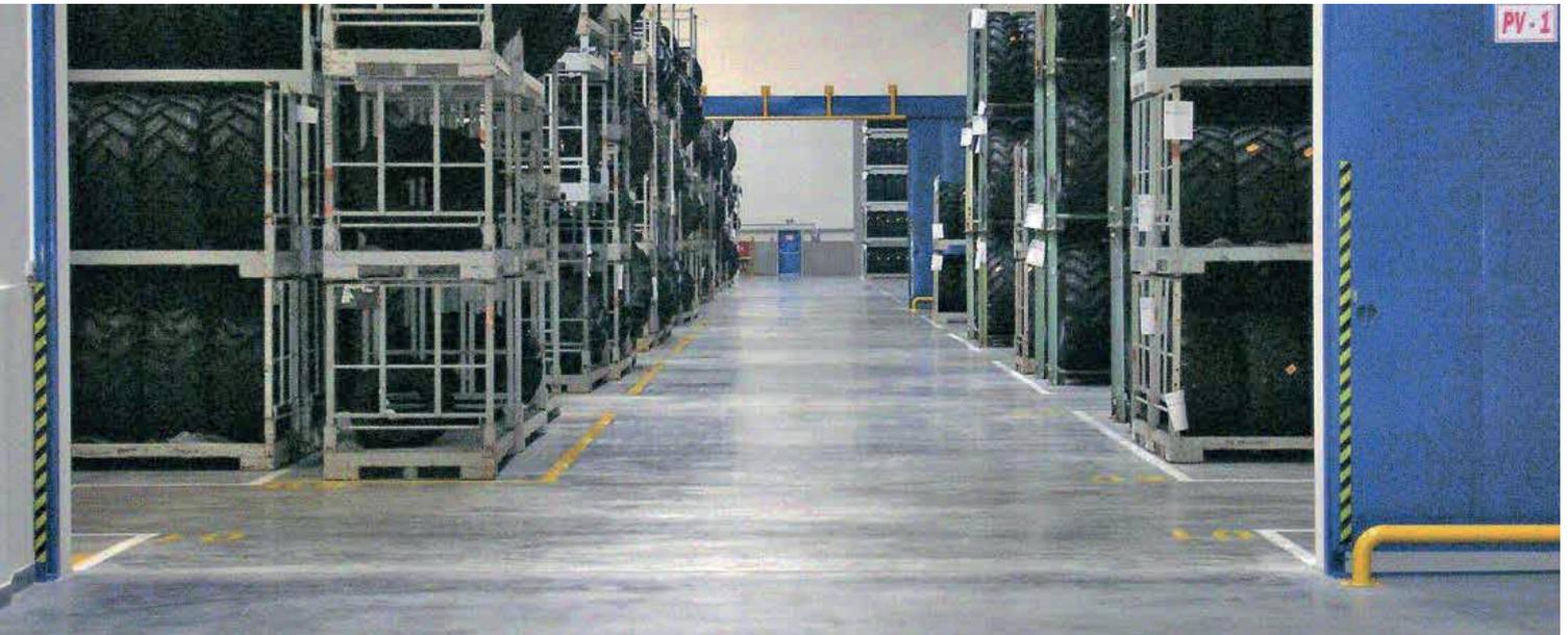
Está compuesto de cemento, pigmentos especiales, aditivos y agregados de cuarzo de gran pureza especialmente gradados y seleccionados de acuerdo con su forma, tamaño y propiedades físicas y mecánicas.
