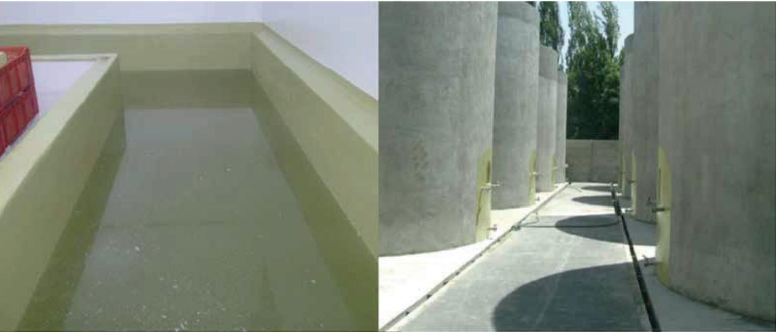
Es un recubrimiento epóxico de dos componentes, de viscosidad mediana, libre de solventes, 100% sólido, para revestimientos de protección química.
