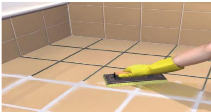
**Sika® Porcelana Blanca**, es un mortero en polvo a base de cemento, polímeros, áridos y aditivos especiales diseñados para el relleno de juntas de 3 a 8 mm de espesor.
