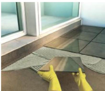
**5** Colocar las baldosas una por una ejerciendo fuerte presión para asegurar el contacto con el pegamento.
