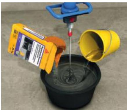
**2** Mezclar manualmente o de preferencia con un mezclador (mínimo 3 minutos) hasta obtener una pasta homogénea, exenta de grumos y de color uniforme. Luego, dejar reposar por 5 minutos.
