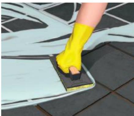
**6** Después de 48 horas aplicar la fragua entre las juntas de las baldosas utilizando **Sika® Porcelana Blanca**.
