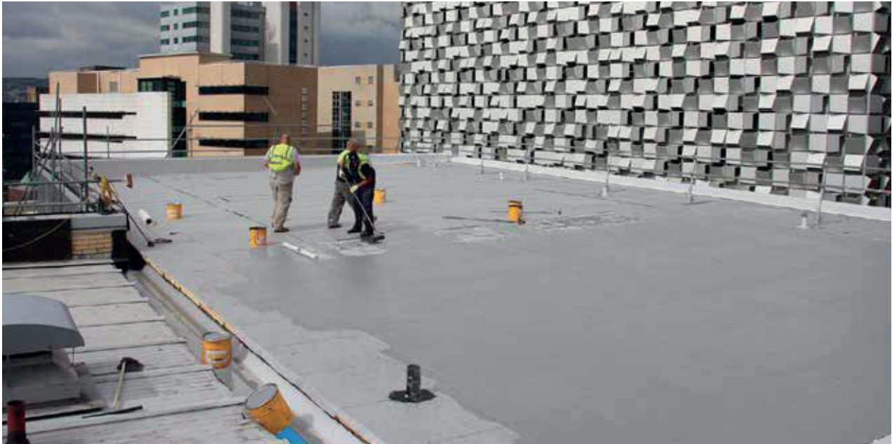
Aplicación de membrana líquida, Hallam University, Sheffield, UK
