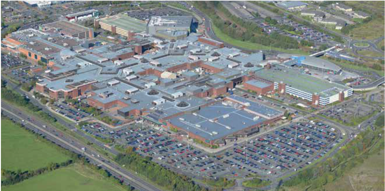
Centro comercial MetroCentre (20.000 m 2 ), Gateshead, Reino Unido
