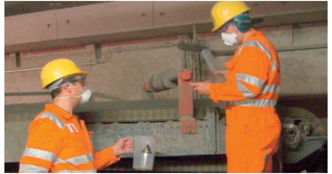
4 Ejecución de ensayos en planta por parte de los expertos Sika.
